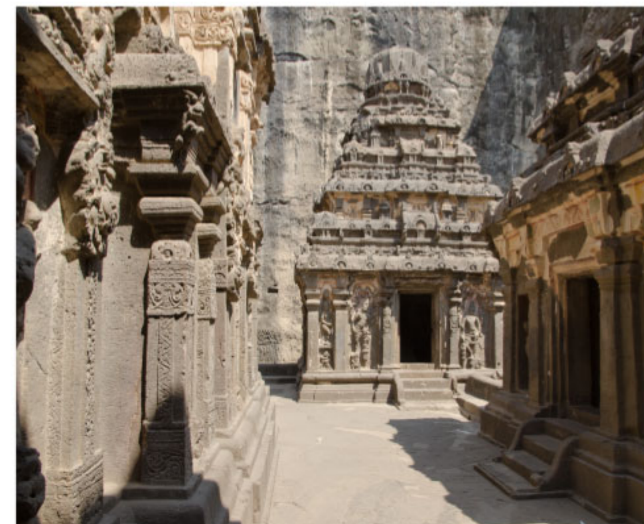
Le temple de Kailâsanâtha à Ellorâ est taillé dans un seul bloc de pierre.
