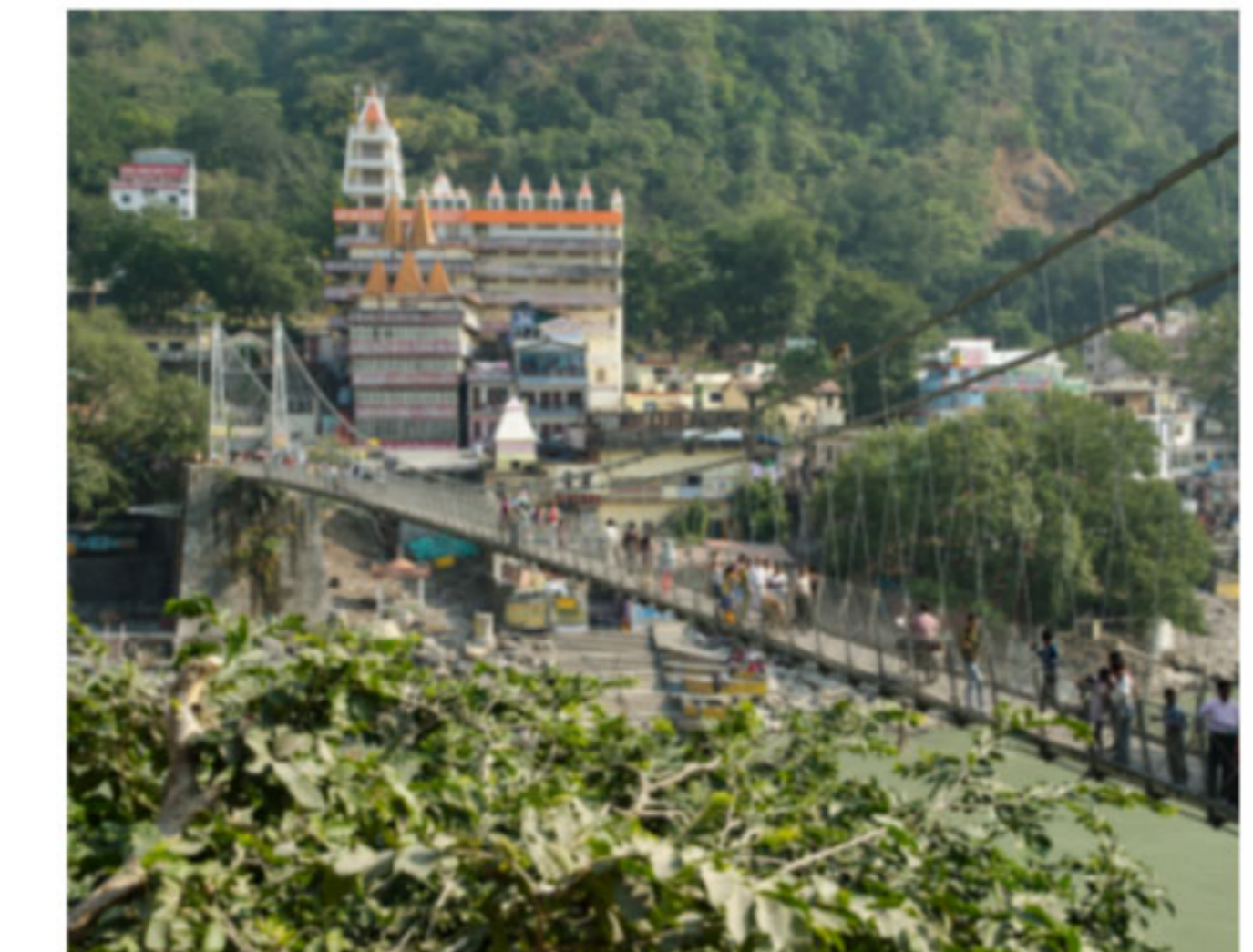
Le pont Lakshman Jhula enjambe les eaux sacrées du Gange à Rishikesh.
