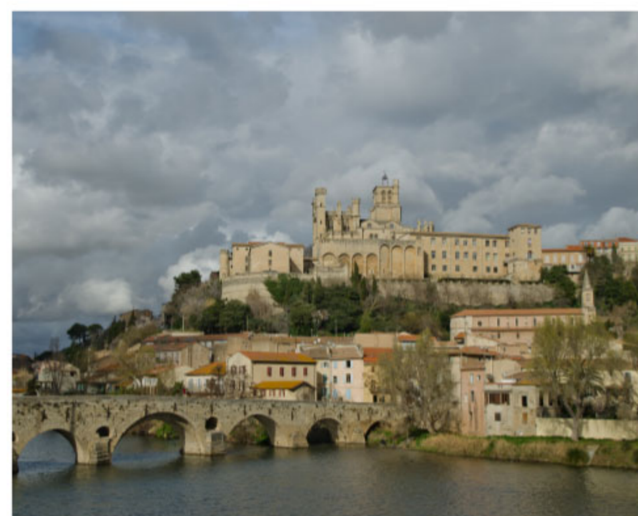
Le Pont Vieux enjambe l'Orb au pied du centre-ville de Béziers.
